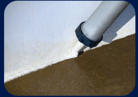
ΒΗΜΑ 3 Επισκευή και σφράγιση ρωγμών και αρμών
